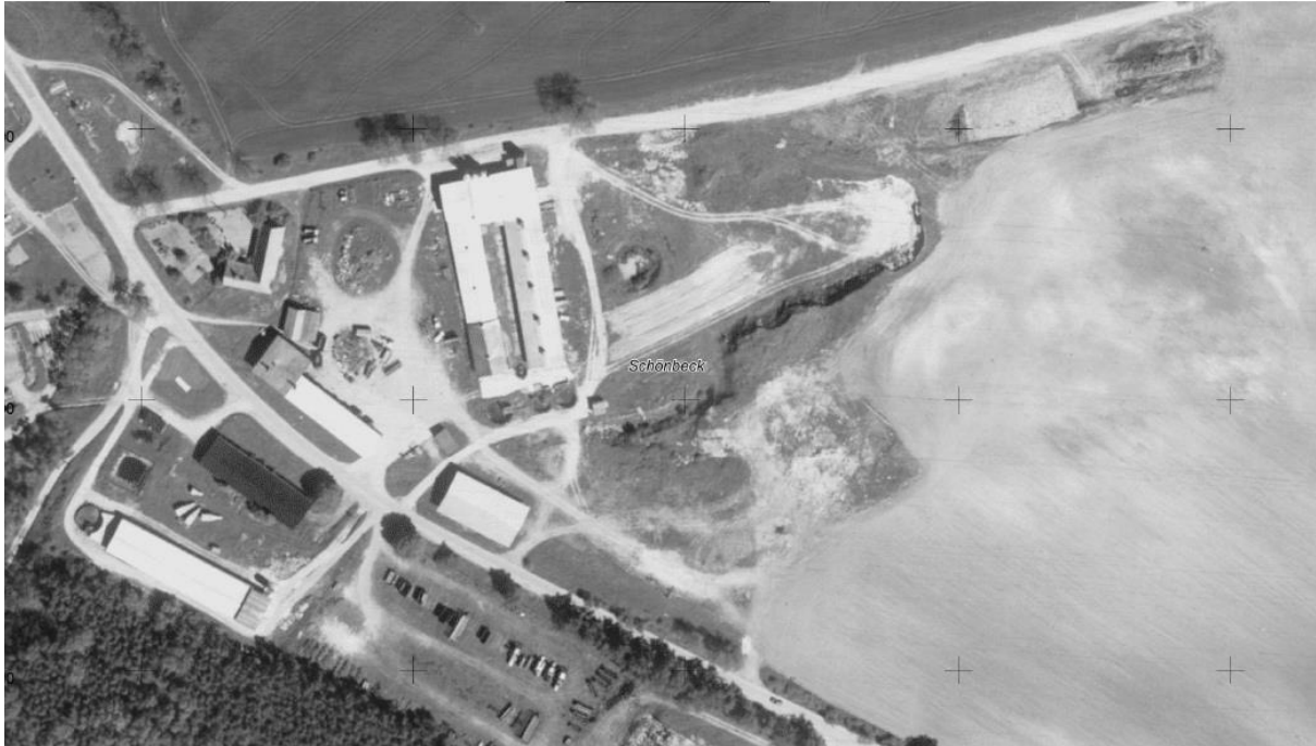
Abbildung 1: ehemalige Tierproduktionsanlage, Kiesabbau und Deponie im Plangeltungsbe- reich auf dem historischen Luftbild von 1991
